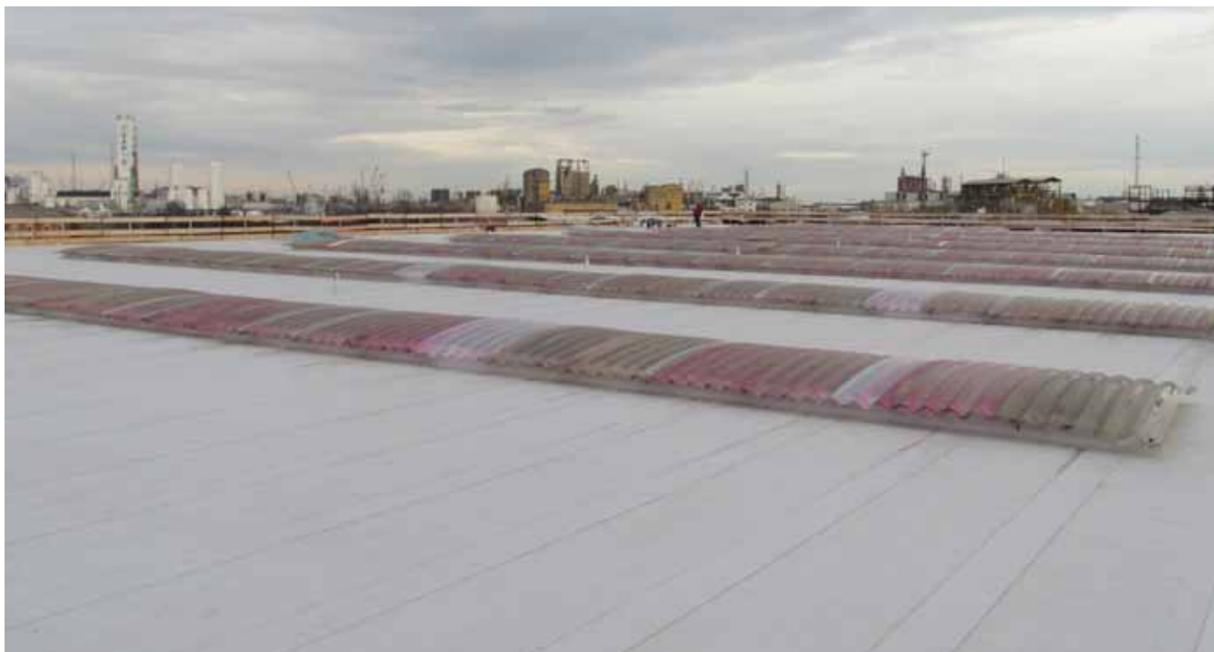
Плоская кровля (панель Isopan Isodeck PVsteel)
